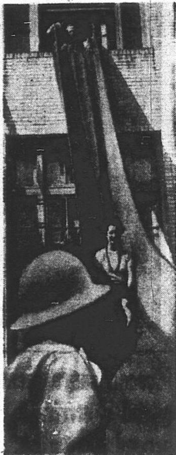
Les directeurs de la défense civile de Pittsburgh ont récemment démontré le fonctionnement d'un nouvel appareil de sauvetage en cas d'incendie, d'abord utilisé en Angleterre lors de la Blitz. Comme on peut le voir, l'invention consiste en un glissement en canvas solidement fixé au rebord de la fenêtre où des personnes sont emprisonnées par les flammes.
