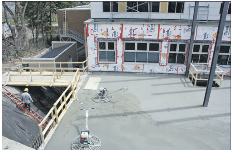
Les travaux avancent rondement pour l'agrandissement prévu.
