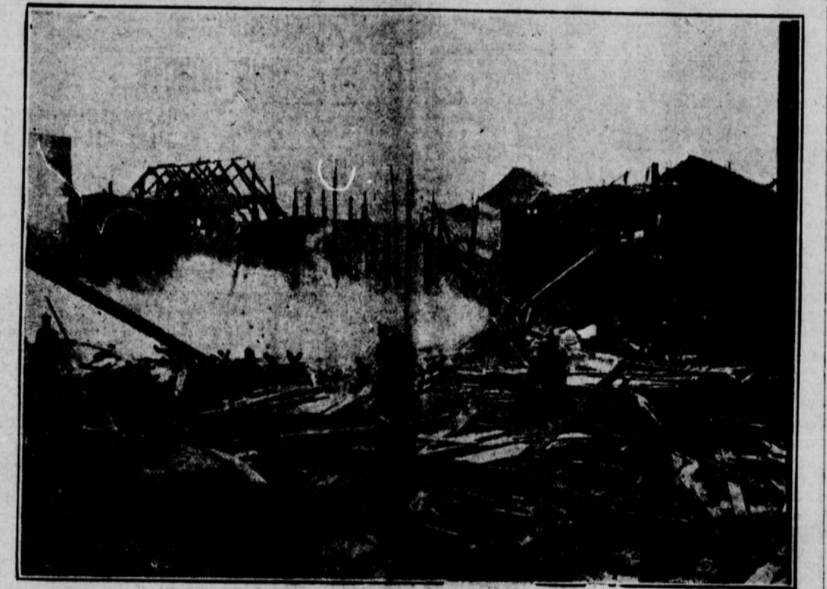
VUE DES DECOMBRES DE LA GLACIERE HENAUULT, détruite, hier, par un incendie. Photographie prise par l'artiste de la PATRIE.
