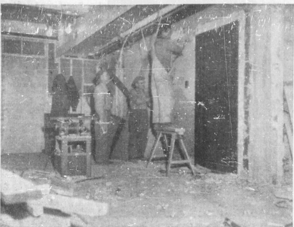
LE REZ-DE-CHAUSSEE de l'hôtel de ville de Sudbury, une fois complètement rénové, ajoutera 1,500 pieds carrés d'espace largement requis pour aider à solutionner les problèmes qui font suite à l'annexion. Les bureaux du sous-officier, M. R.L. O'Connor, seront démenagés au sous-sol, afin de donner plus d'espace au département du trésor et au chef du contentieux municipal. D'autres
