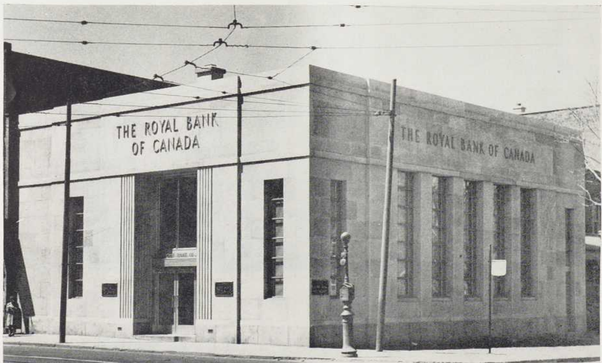
BANQUE ROYALE DU CANADA AVENUE VAN-HORNE, OUTREMONT
