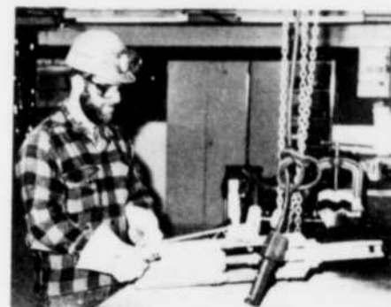
Renaud Savoie, mécanicien, s'affaire à la réparation d'une valve de dépoussiéreur.
