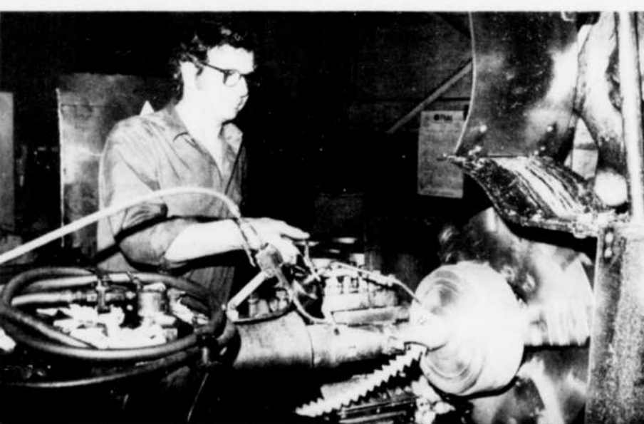
Toujours aux ateliers d'usinage de SAT, voici un tour à tourelle opéré par Gabriel Tremblay.
