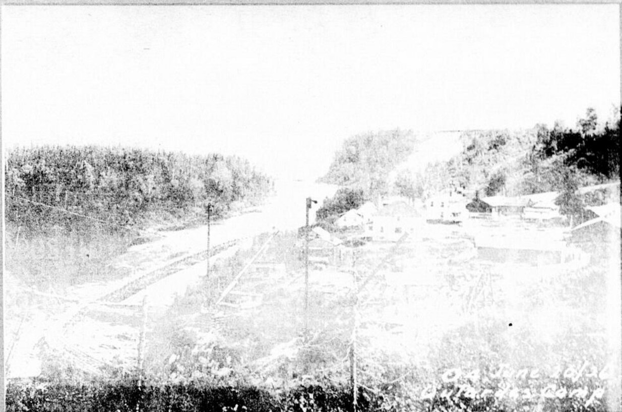
Site de la Centrale Outardes & maisons. 20 Juin 1936. G. L. P. 1936
