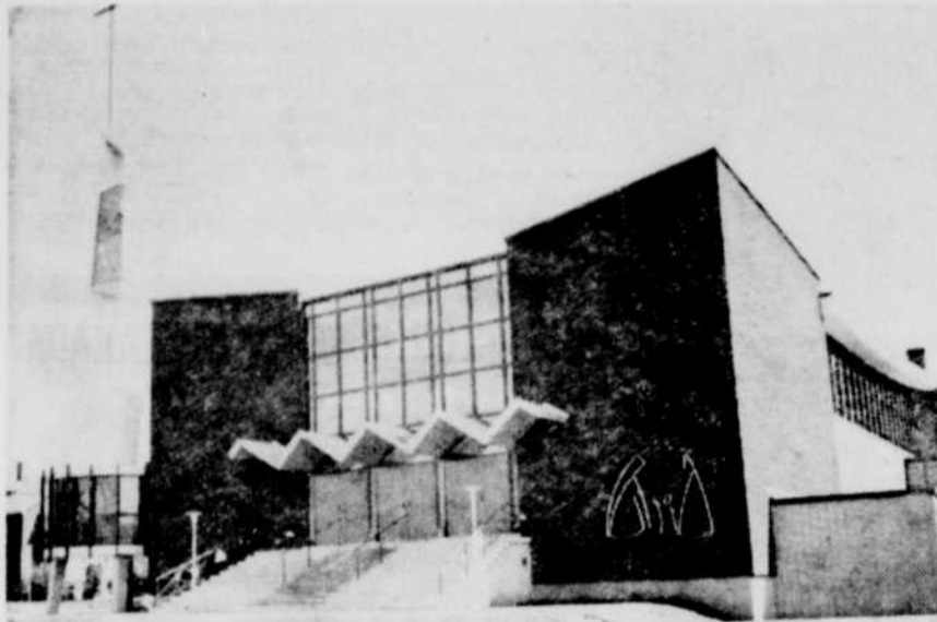
L'église Ste-Famille, située à l'angle des rues Papineau et 8e Avenue, a été construite il y a quelques années seulement. D'après les observateurs, il s'agirait de l'une des églises les plus belles et les plus fonctionnelles de toute la province.
