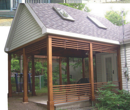
Terrasse extérieur avec toiture sur pieux : projet de 30 000 $.
