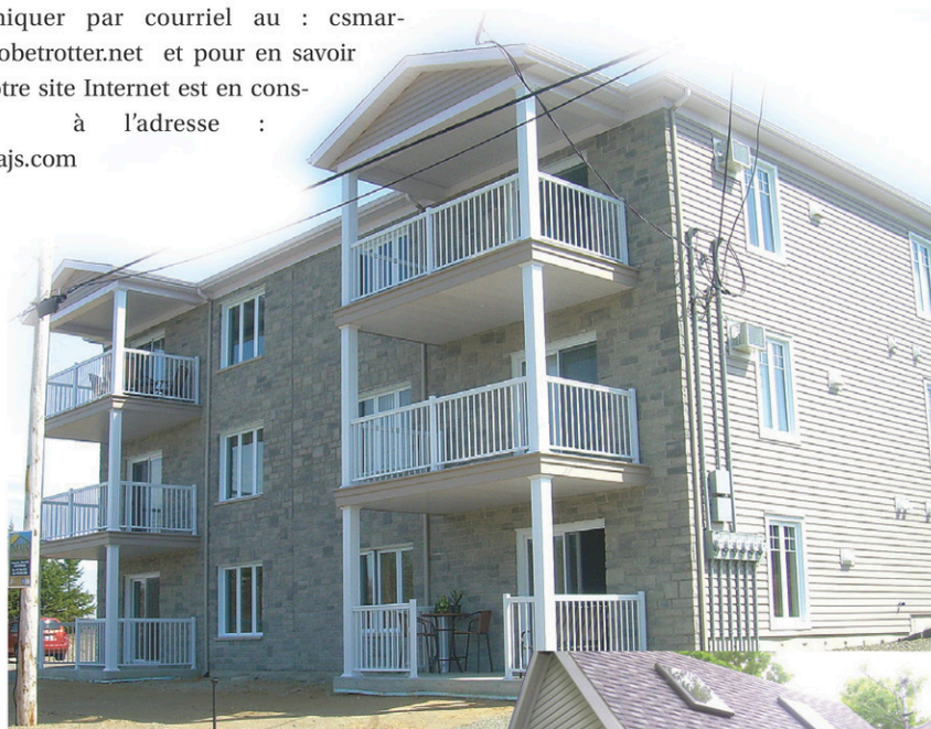
Immeuble neuf de six logements. Coût de construction : 500 000 $
