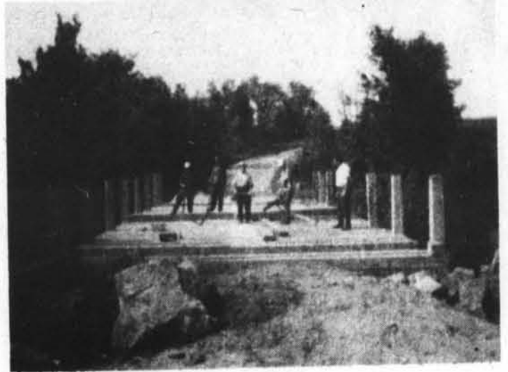
TRAVAUX DANS LA PAROISSE DE ST. A. A.
