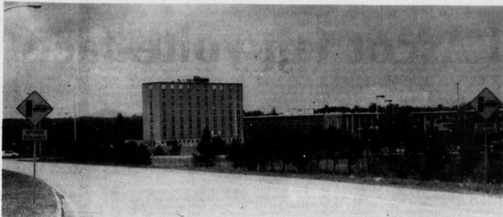
Les panneaux de signalisation indiquant la sortie du Triplet sur le boulevard Université ainsi que la présence d'autobus scolaires étaient installés hier. Cette mesure vise à améliorer la sécurité à la sortie de la polyvalente.
