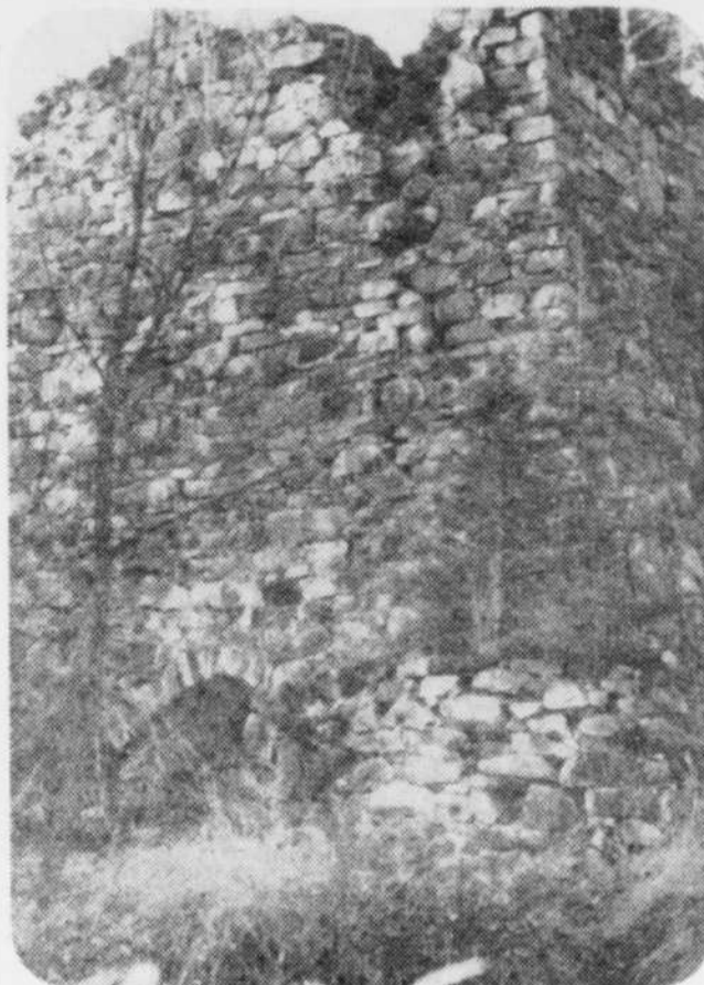
Les ruines du haut-fourneau des vieilles forges du Saint-Maurice, fondées au 18e siècle près de Trois-Rivières.
