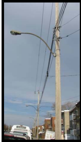
Lampadaire orienté de type routier (col de cygne) et lampadaire offrant un éclairage à l'échelle du piéton (éclairage bas)
