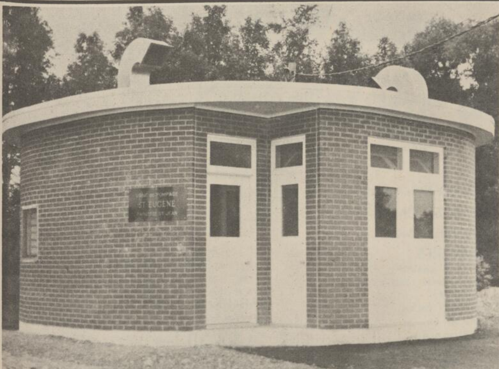
La construction de l'usine de pompage de la paroisse Saint-Jean l'Evangéliste est maintenant terminée par l'érection de cette bâtisse qui recouvre les pompes. Le conseil de la paroisse a décidé de faire construire cette bâtisse pour éliminer les senteurs et éviter tout dommage. Le coût de cet édifice s'élève à $4,500.
