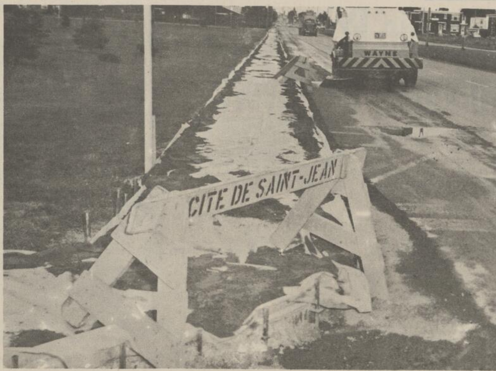
Les employés de la voirie municipale, sous la direction de M. Pierre Berger, surintendant des travaux publics, ont terminé la construction d'un trottoir sur le côté ouest du Boulevard du Séminaire, entre le Boulevard Montcalm et la rue Mayrand. Ce trottoir sera très bien accueilli par les milliers d'étudiants qui fréquenteront le Séminaire de Saint-Jean à partir du 4 septembre prochain.
