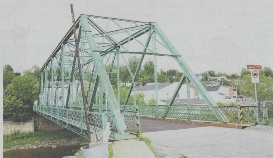
La construction d'un deuxième pont à Saint-Côme demeure la priorité. (Photo TC Media - Archives)
