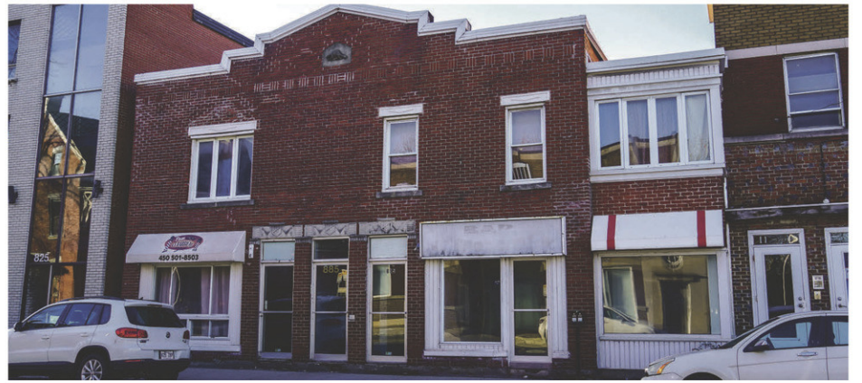
Ce bâtiment de l'avenue Laframboise accueillera une buanderie communautaire et les locaux administratifs d'Habitations Maska en plus de conserver 11 logements abordables. Photothèque | Le Courrier ©
