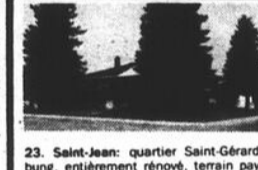
23. Saint-Jean: quartier Saint-Gérard, bung. entièrement rénové, terrain paysager. André Sévigny
