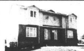
RM 48-49. SAINT-JEAN: construction 1987, occupation immédiate, secteur recherche. Alain Gibeau
