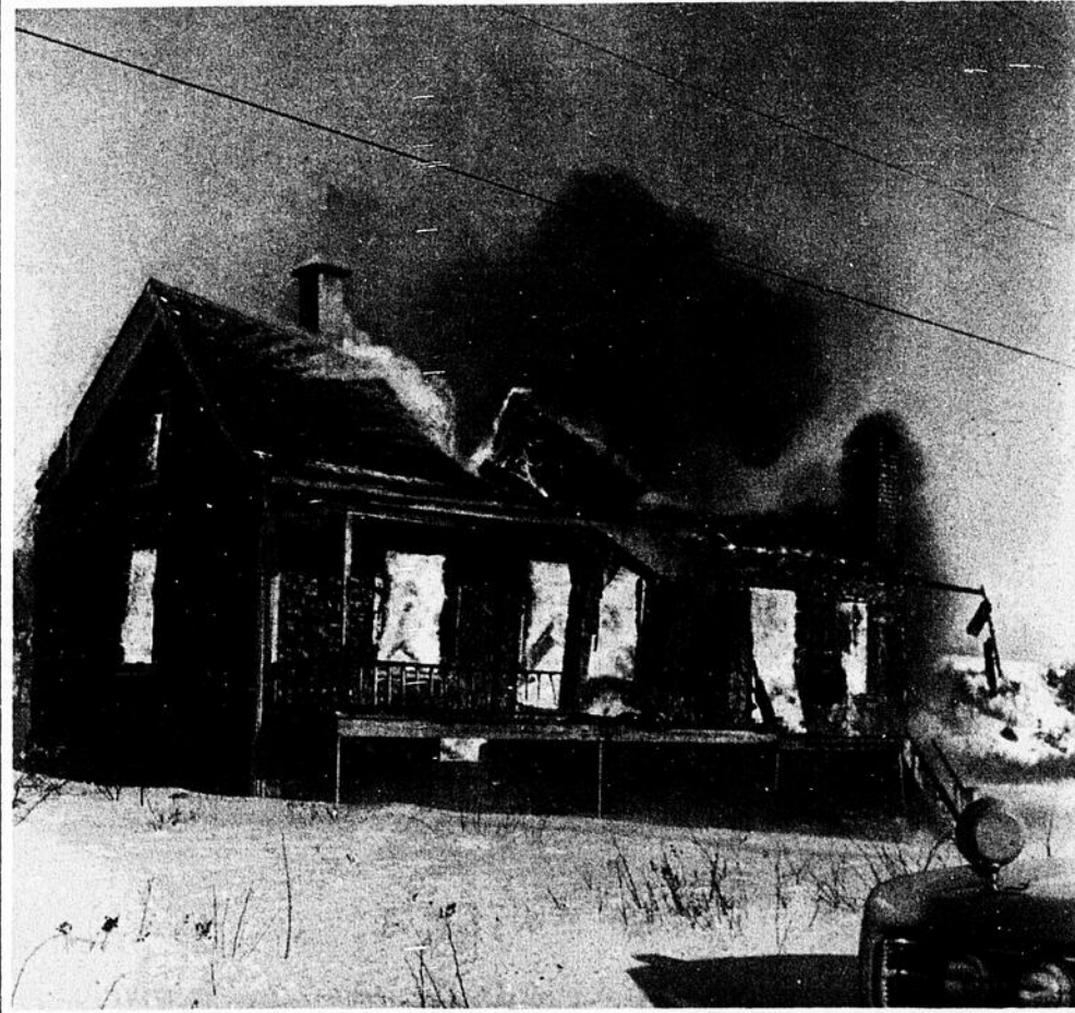
SEPT MAISONS INCENDIEES. — Dans le cadre de son programme de rénovation urbaine à l'entrée ouest de la Ville, la Cité de Montmagny a fait détruire sept maisons par le feu, samedi. Ces maisons et les terrains étaient depuis peu la propriété de la Ville qui a déboursé $16,710. pour cet achat. Les pompiers de Montmagny ont suivi avec un oeil vigilant le travail de l'élément destructeur. Ce plan des autorités magnymontoises ressemble à ce qui fut exécuté il y a quelques mois dans l'avenue du Camp.
