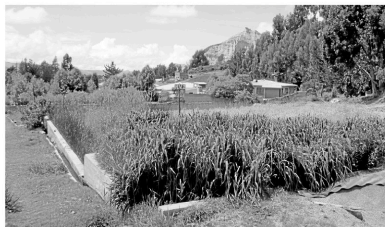
À la fromagerie Flor de leche, à Achocalla en Bolivie, des champs d'épuration à base de plantes et de sable servent à filtrer l'eau de production.
