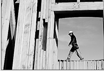
Travailleur sur un chantier de construction, à Dublin.
