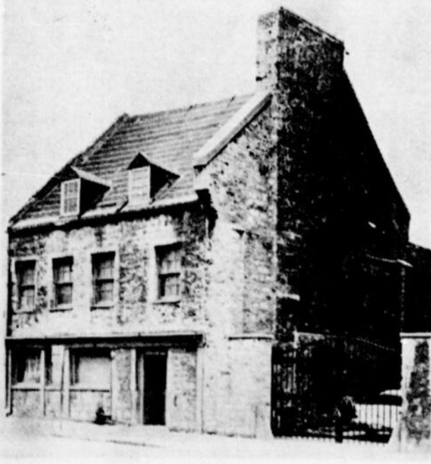
"LA MAISON DES ARTS LA SAUVEGARDE", dans son état actuel, avant la restauration qui en fera un centre d'art.
