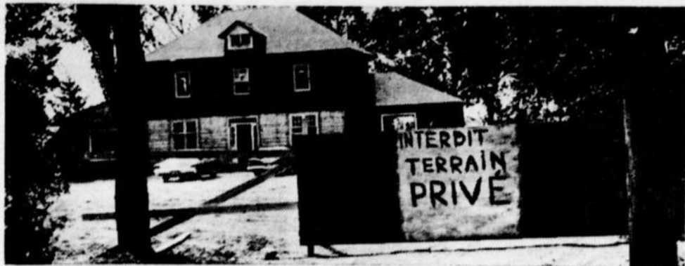
Face à l'unique auberge de Saint-Mathias, voici la propriété où l'on a découvert du gaz naturel. Le propriétaire a dû en interdire l'entrée aux gens trop curieux...
