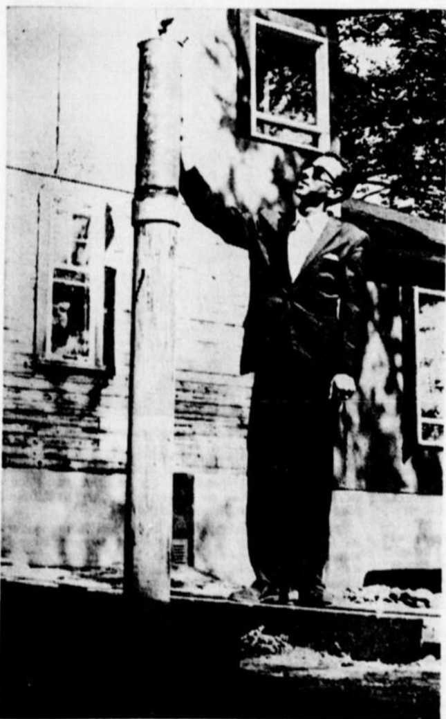
Avec une flamme de 15 pieds, le gaz côtoyait les murs de cette nouvelle maison. M. Couture explique ici le fonctionnement du réducteur de pression employé pour enrayer un tel danger.
