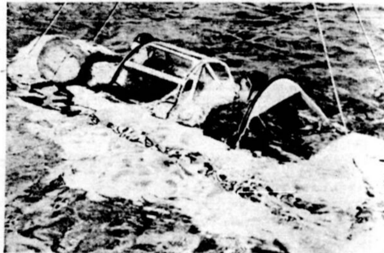
Pour enseigner aux apprentis-aviateurs à sauver leur vie, quand leur avion tombe à la mer, on se sert de cet appareil à l'école d'aviation navale de Corpus-Christi, Texas. C'est une section d'un avion à deux places qu'on lance dans une piscine et qui sombre promptement. Tout habillés, ces deux étudiants n'ont que 25 secondes pour sortir de l'avion avec leurs appareils de sauvetage, gonfler leurs vestons et leur radeau de caoutchouc.
