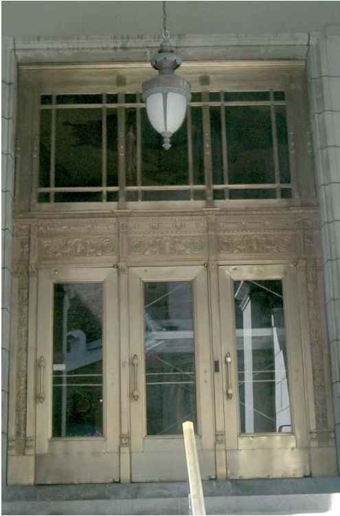
Photo prise après le travail de restauration des portes en bronze du Ministère des Finances à Québec.
