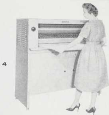
La Revolute Rochette — Une nouvelle machine de tirage diazo à sec, pourvue d'un simple régulateur à bouton unique, et de rouleaux de développement perforés, en acier inoxydable.
