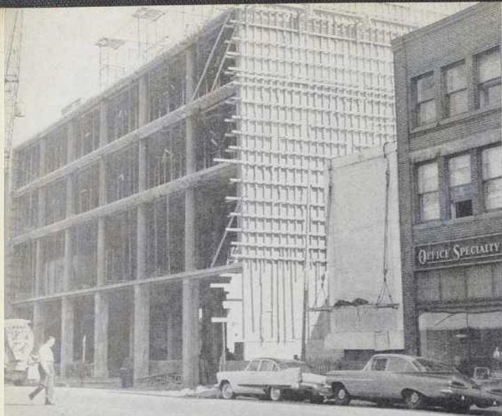
Erection de la charpente
