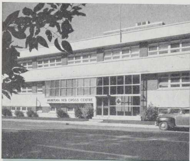
L'entrée et les fenêtres du nouveau Centre de la Croix Rouge manitobaine, rue Osborne, à Winnipeg, sont en acier inoxydable au nickel. Fabricant: Dominion Bronze and Iron Ltd., Winnipeg. Architectes: Moody and Moore, Winnipeg.
