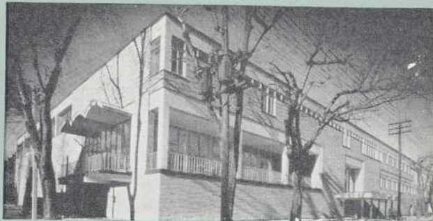
Nouveau gymnase des étudiantes de l'Université de Toronto. Les cadres de fenêtres et les meneaux sont en acier inoxydable au nickel. Fabricant: Cresswell-Pomeroy Ltd. Architectes: Fleury, Arthur and Barclay.
