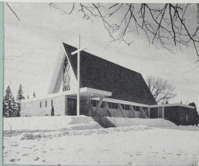
Des meneaux en acier inoxydable au nickel rehaussent la beauté des lignes de l'église St-George, à Byron, Ontario. Fabricant: Macotta Company of Canada, Limited. Architectes: Blackwell and Hagarty.
