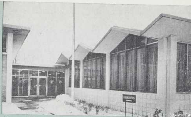
L'entrée et les murs vitrés du nouvel immeuble abritant les bureaux de Parke Davis & Company, à Montréal, sont en acier inoxydable au nickel et ont été fabriqués par Canadian Pittsburgh Industries Limited, de Montréal. Architecte: Paul H. Lapointe. Ingénieur: R. P. Steketeet, c/o Giffels & Vallet of Canada, Ltd.
