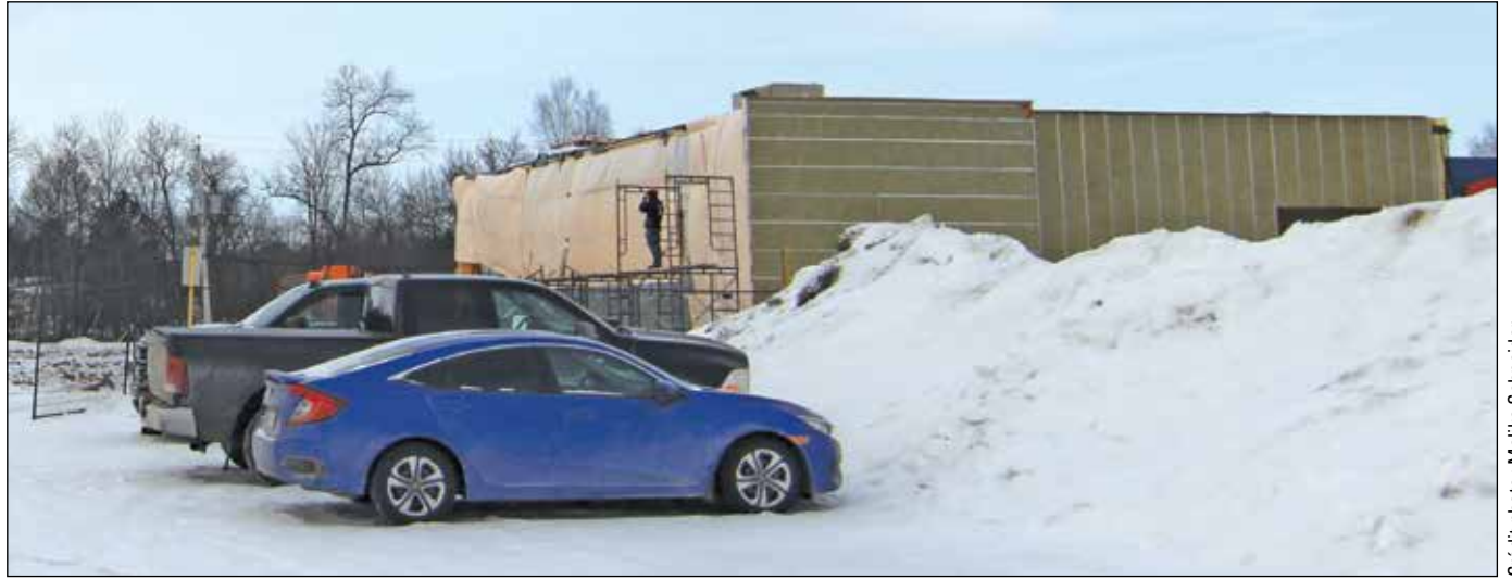
Les travaux ont débuté progressivement alors que tous les commerces du Mail Cap-Rouge restent ouverts durant toute la durée de ceux-ci. État des lieux en date du 30 janvier 2018.
