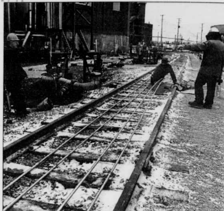
◆ Le CPA a récemment complété un projet d'envergure qui consistait notamment à réparer les voies ferrées qui assurent la livraison du brai liquide.
