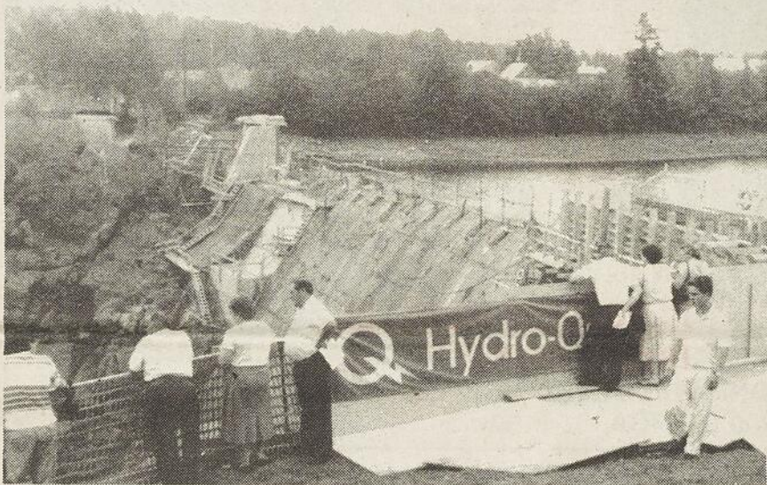
Près de 800 personnes ont répondu à l'invitation d'Hydro-Québec à venir visiter les travaux de réfection du barrage de St-Raphaël.
