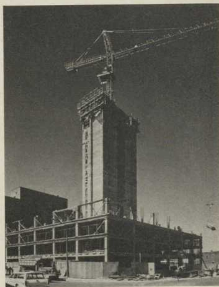
Erection des tours jumelles à l'aide de coffrages coulissants
