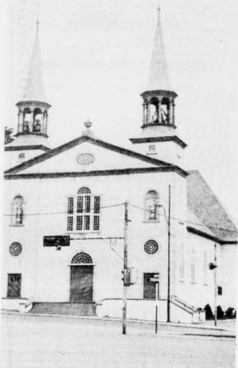
L'église Saint-Charles-Borromée, dans l'arrondissement historique du Trait-Carré, est classée monument historique et soumise aux normes édictées par le ministère des Affaires culturelles.
