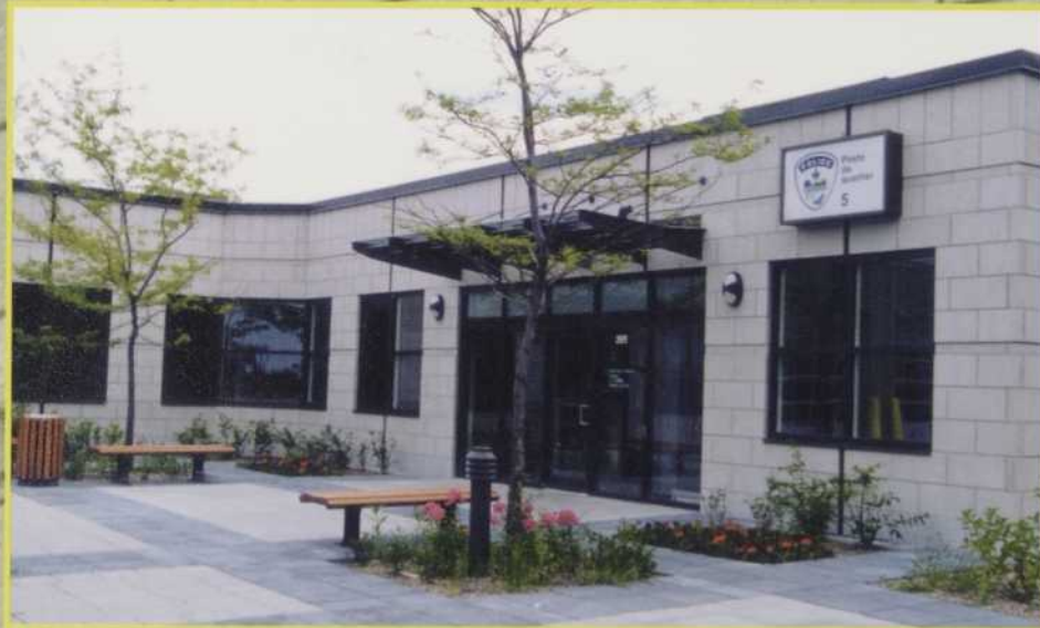
Police, Poste de Quartier Pointe-Claire, Québec Architectes Tolchinsky & Goodz
