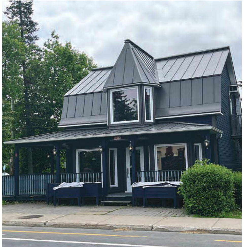
Le restaurant est remis en vente afin d'en conserver la vocation. (Photo : Chloé-Anne Touma)
