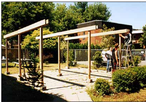
Montage des poutres porteuses.
