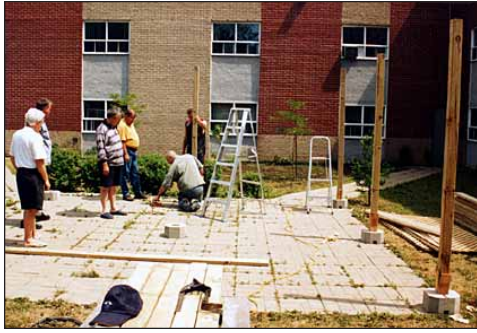
Préparation de la surface.
