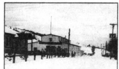
La Compagnie Cadorette à Saint-Jean-des-Piles, en 1945. Source: Le Nouvelliste.
