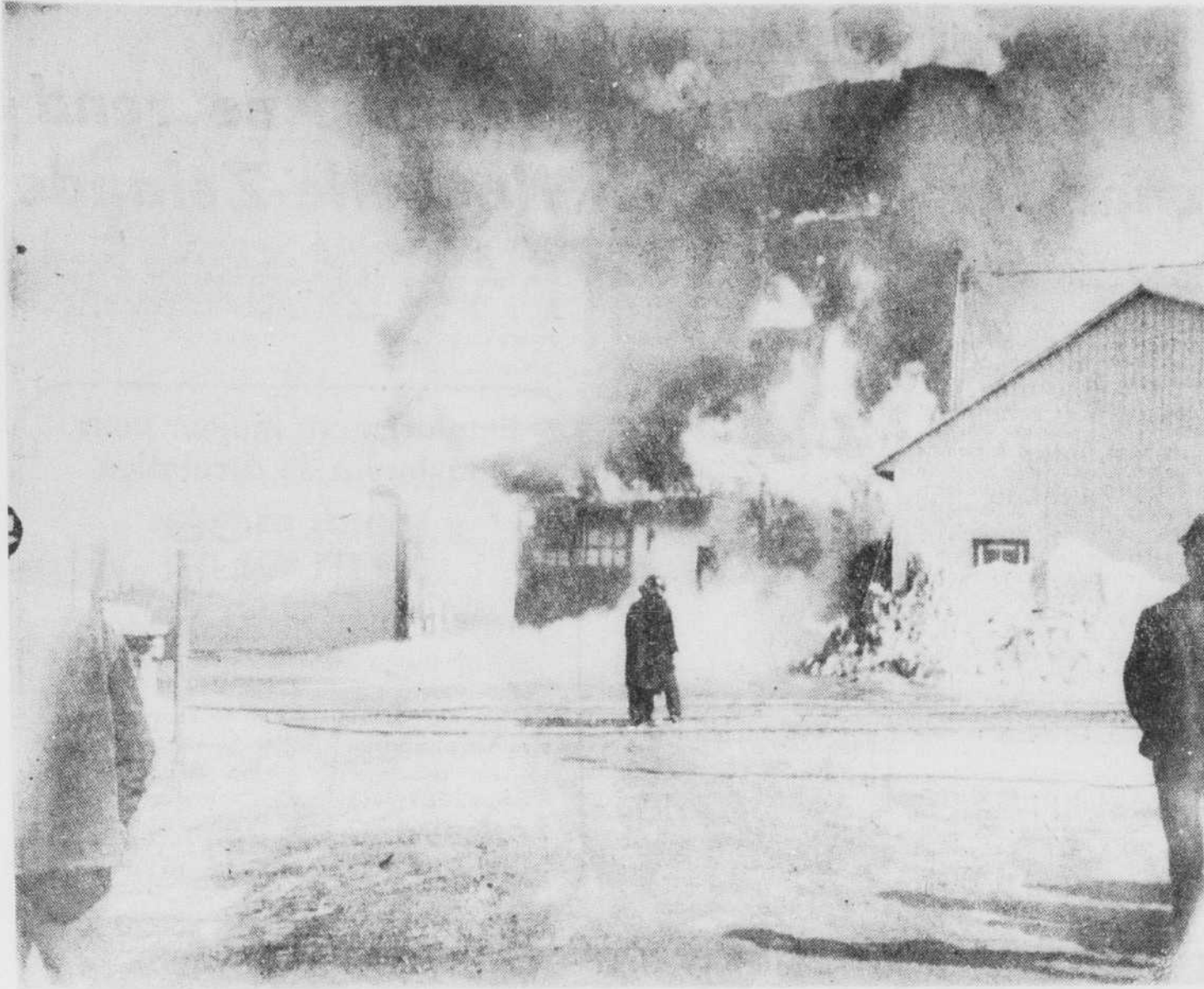
La meunerie de Honfleur n'est plus maintenant qu'un amas de ruines fumantes.
