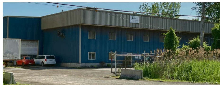
Triumvirate Environnemental est installé au 1223, montée de la Pomme-d'Or, à Contrecoeur.
