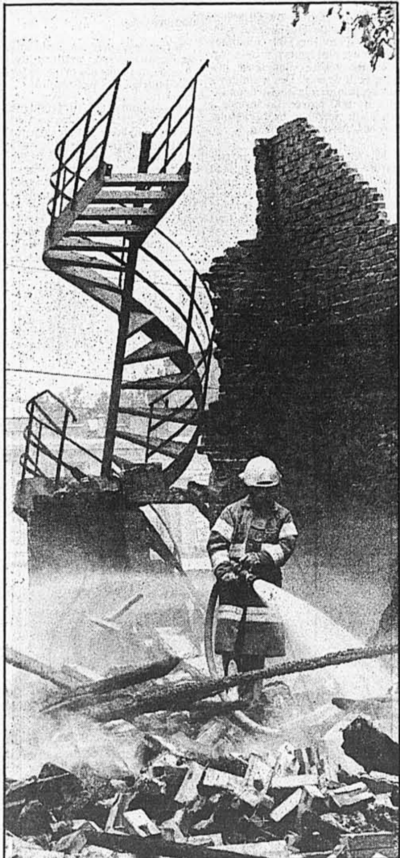
Hier midi, les pompiers arrosaient encore les débris fumants de l'immeuble en rénovation de la rue Jacques-Hertel, incendié au petit matin. PHOTOS RENE PICARD, La Presse
