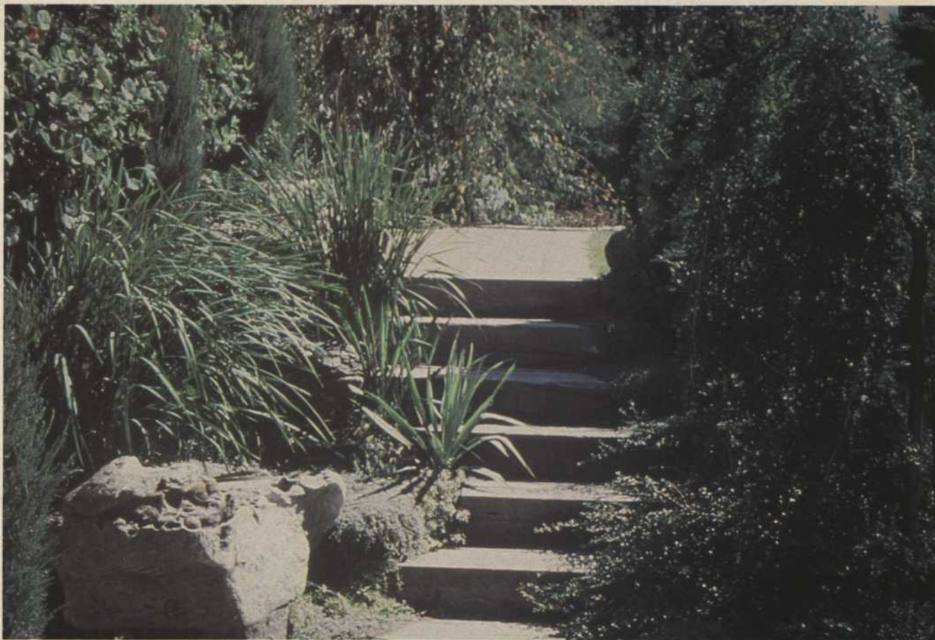
Escalier en madriers traités contre la pourriture et qui permet de changer de niveau à même une rocaille de plantes vivaces. En haut de l'escalier, on retrouve le début du patio arrière fait en pavé-uni couleur chamois.
