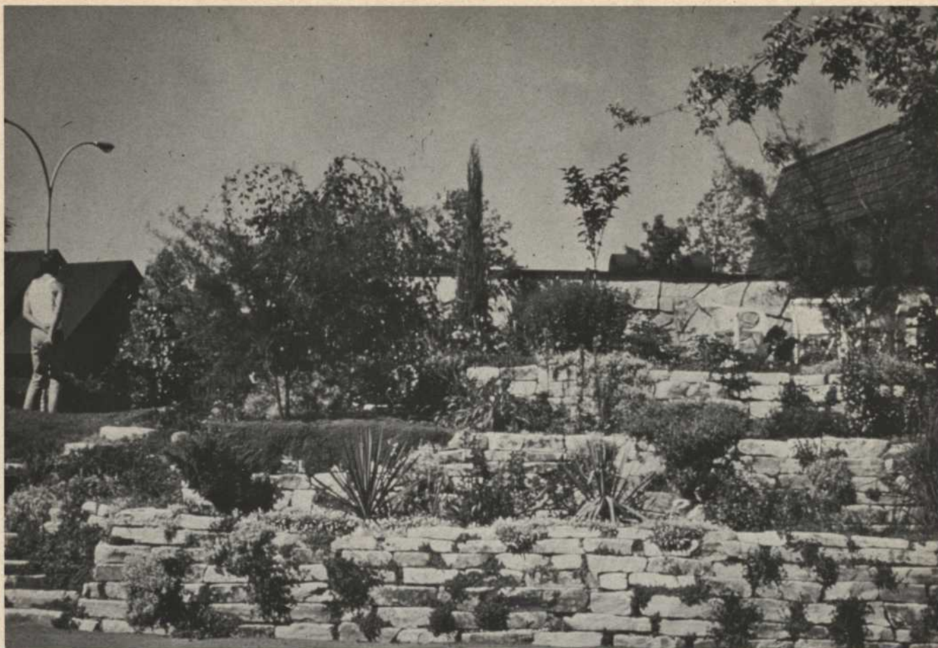
Pièce de résistance de l'aménagement paysager, un magnifique jardin en gradins, créé par trois murets de soutènement en pierres sèches de St-Canut. Du côté gauche, on peut voir l'escalier
