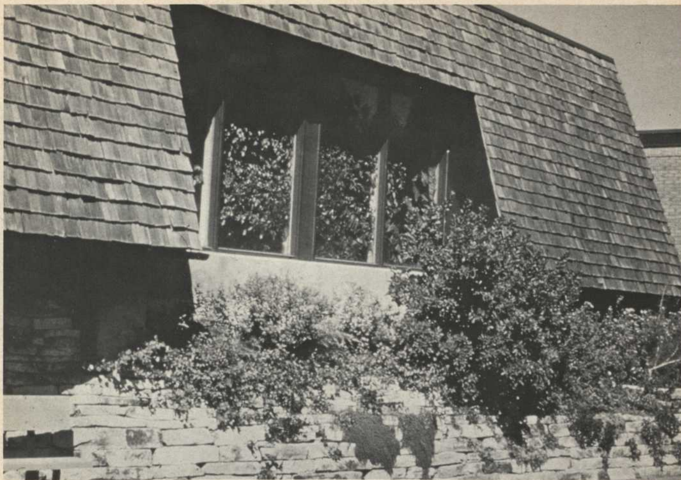
Muret de soutènement en pierres sèches de St-Canut, décoré par des arbustes feuillus et des plantes de rocailles qui poussent entre
