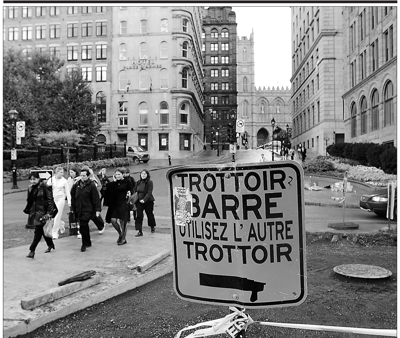
Photo MARTIN CHAMBERLAND, La Presse Les travaux qui se poursuivent depuis des mois autour du Palais des congrès de Montréal causent de nombreux inconforts, notamment dans la rue Saint-Antoine. Les piétons, nombreux dans le secteur, ont intérêt à bien suivre les indications.
