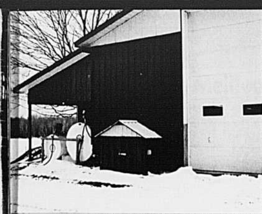
La porte du garage a été relocalisée à une extrémité pour l'agrandir en largeur et en hauteur. À gauche, on voit l'appentis qui abrite les réservoirs à carburant et des pièces de métal ou d'équipements.
