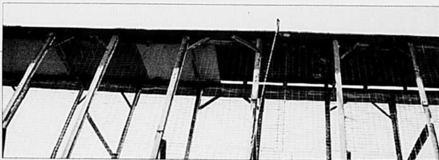
C'est en tirant sur une corde que le producteur peut ouvrir et fermer le toit du crib.
