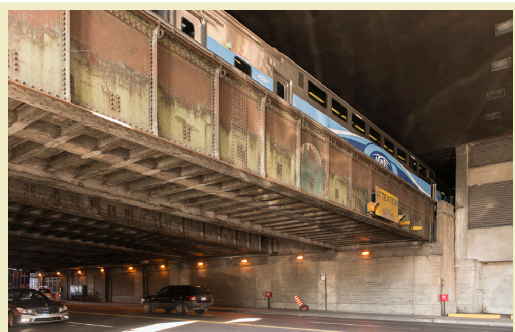
Viaduc ferroviaire Saint-Antoine
