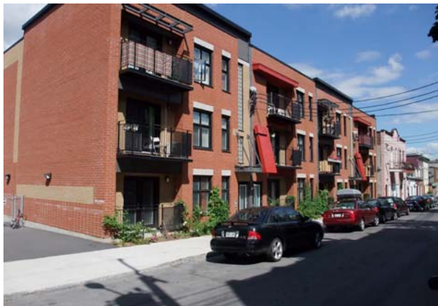
Figure 8 : Photo de la façade, rue Coloniale
