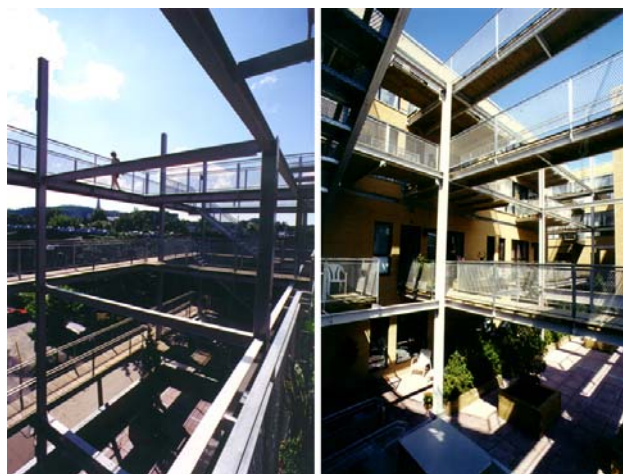
Figure 82 : Photo des coursives, des terrasses privées et de la cour intérieure
