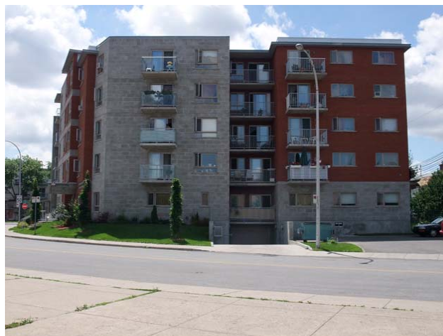
Figure 52 : Photo de la façade comprenant l'accès au sous-sol, rue Terbois
