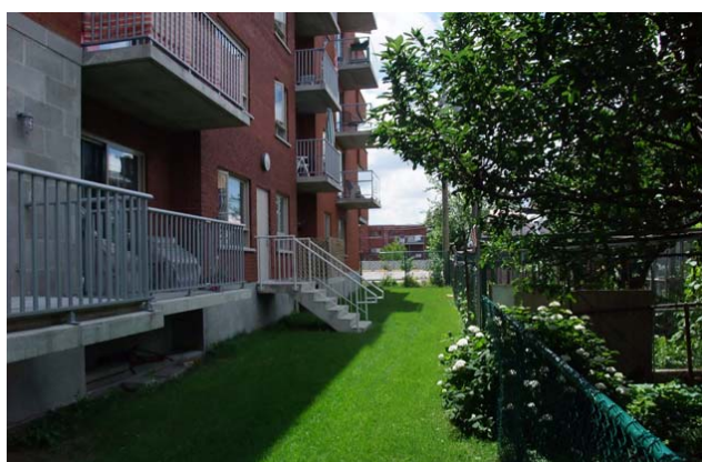
Figure 51 : Photo de la cour arrière
