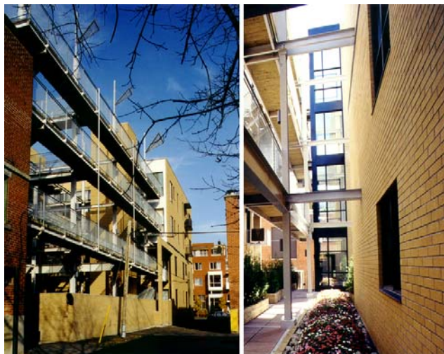
Figure 75 : Photo des coursives et de l'ascenseur © Robert Etcheverry
