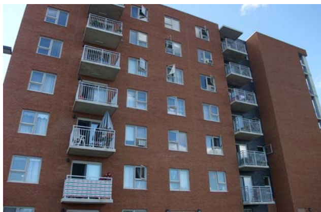
Figure 34 : Photo de la façade donnant sur le stationnement
