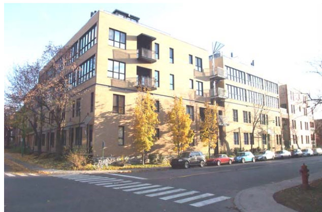
Figure 74 : Photo de la façade principale, phase IV, rue Ducharme
