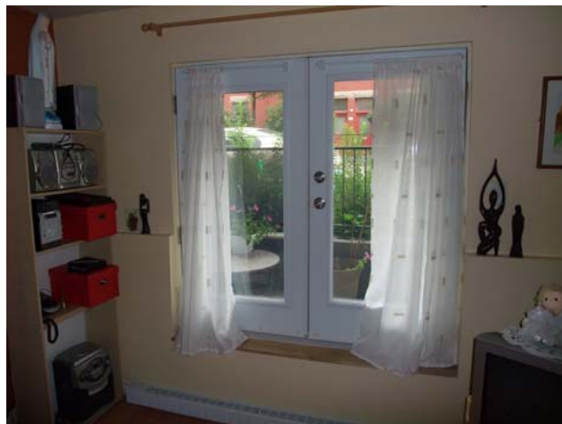
Figure 19 : Photo de la fenêtre du salon d'un logement en « demi sous-sol », donnant sur la rue de Bullion
