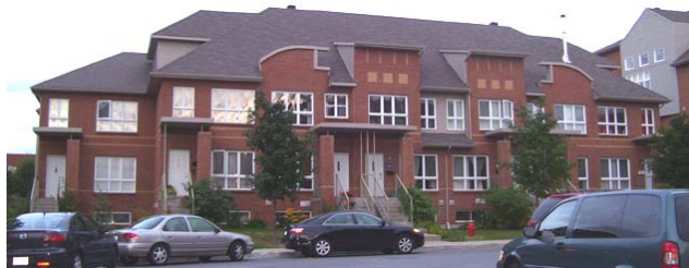
Figure 58 : Photo de maison en rangée (bâtiment C)
