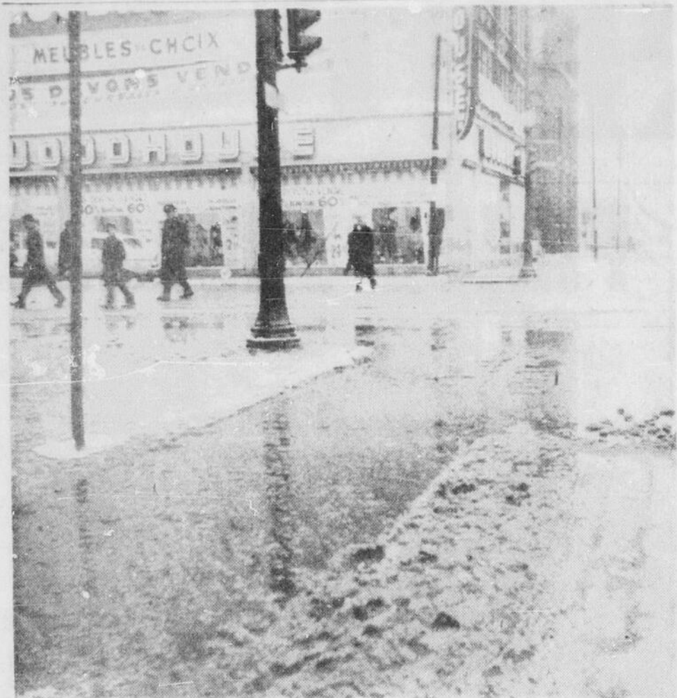
SIGNES PRINTANIERIS : Le printemps serait-il déjà à notre porte ? Il y a de quoi à s'y méprendre en jetant un coup d'œil sur la photo ci-haut. Une mare de six pouces de profondeur borde le trottoir au croisement du boulevard Charest et de la rue de la Couronne.
