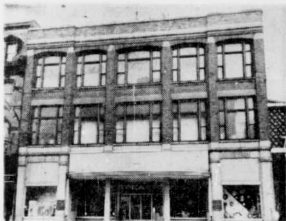
J. S. Mitchell. — A la quincaillerie J. S. Mitchell, sise rue Wellington Nord, monsieur pourra se procurer des outils pour bricoler, des articles de sport; madame pourra acheter des appareils électriques, de la verrerie, etc. A cette quincaillerie, où l'atmosphère est des plus accueillantes, le client n'a que l'embarras du choix.
