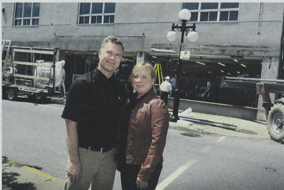
Les travaux vont bon train au marché d'alimentation opéré par Ghislain St-Amand et Josée Déry. Photo François Larivière | Le Courrier ©
