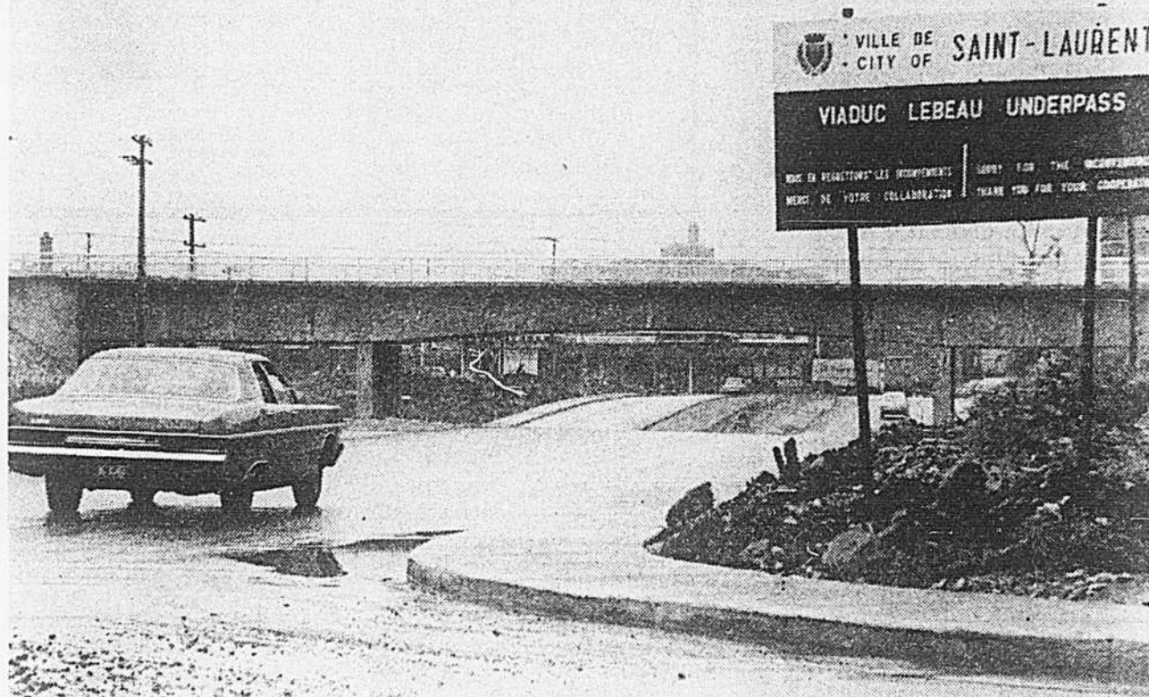
Le viaduc Lebeau est ouvert à la circulation depuis quelques jours à Saint-Laurent. Construit au coût de $750,000, il relie Côte-Vertu au boulevard métropolitain.
