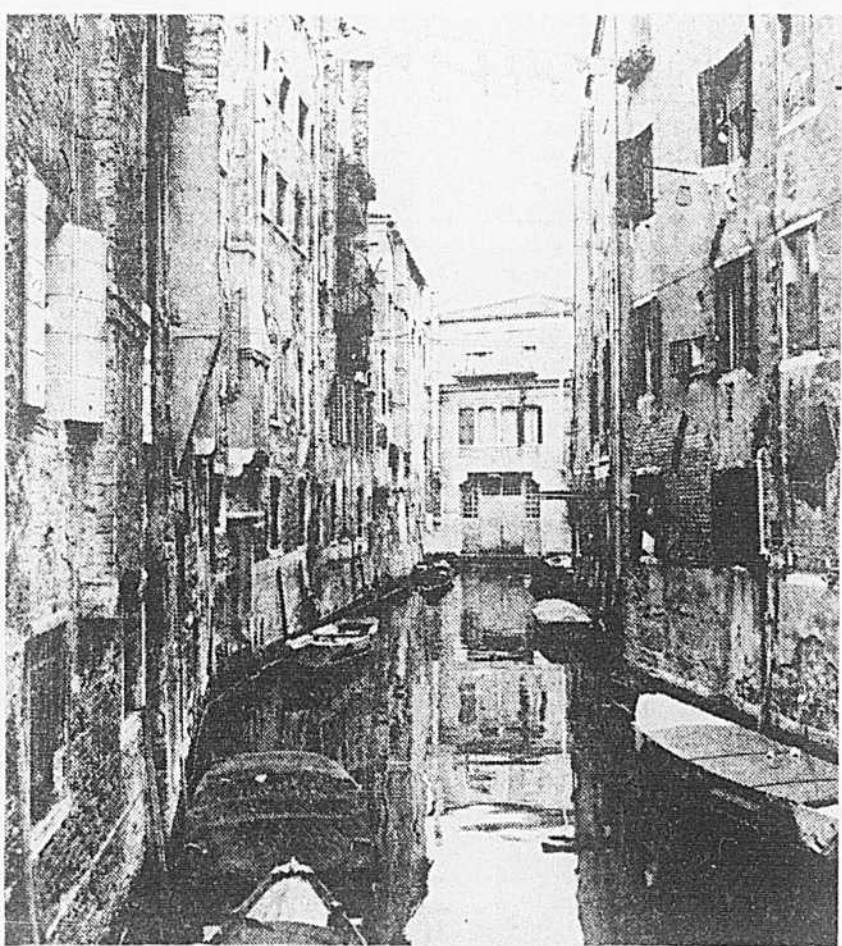
Venise se dégrade d'année en année et s'enfonce progressivement dans la lagune. Ses édifices prennent lentement des allures de ruines parce que personne n'y habite. Les inondations successives et les courants trop rapides érodent la base des bâtiments. L'humidité et la pollution de l'air altèrent les marbres et les peintures. Ci-dessus, un des canaux de la cité, dans l'ancien ghetto de Venise.
