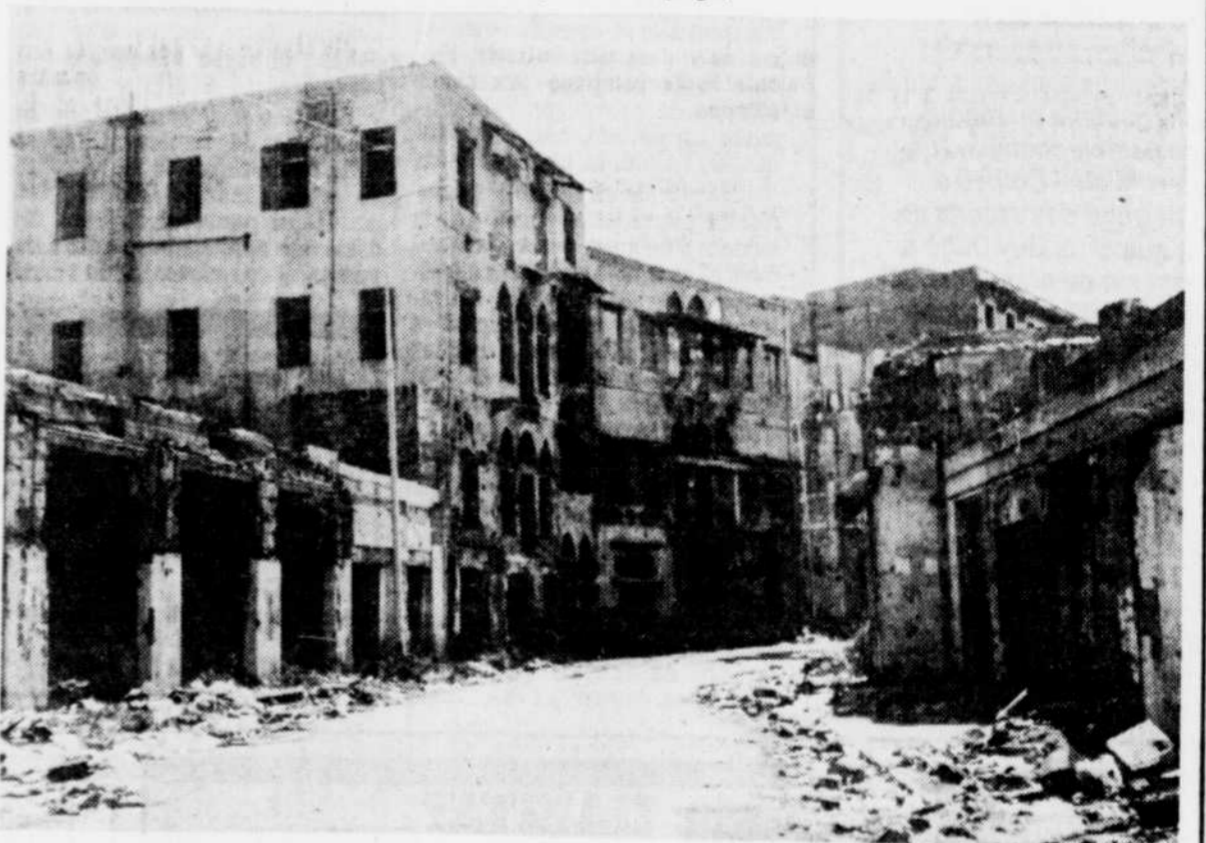
Beyrouth demeure une ville très belle malgré les destructions. Ci-dessus, un secteur où passe la ligne de démarcation dans Beyrouth-Est.
