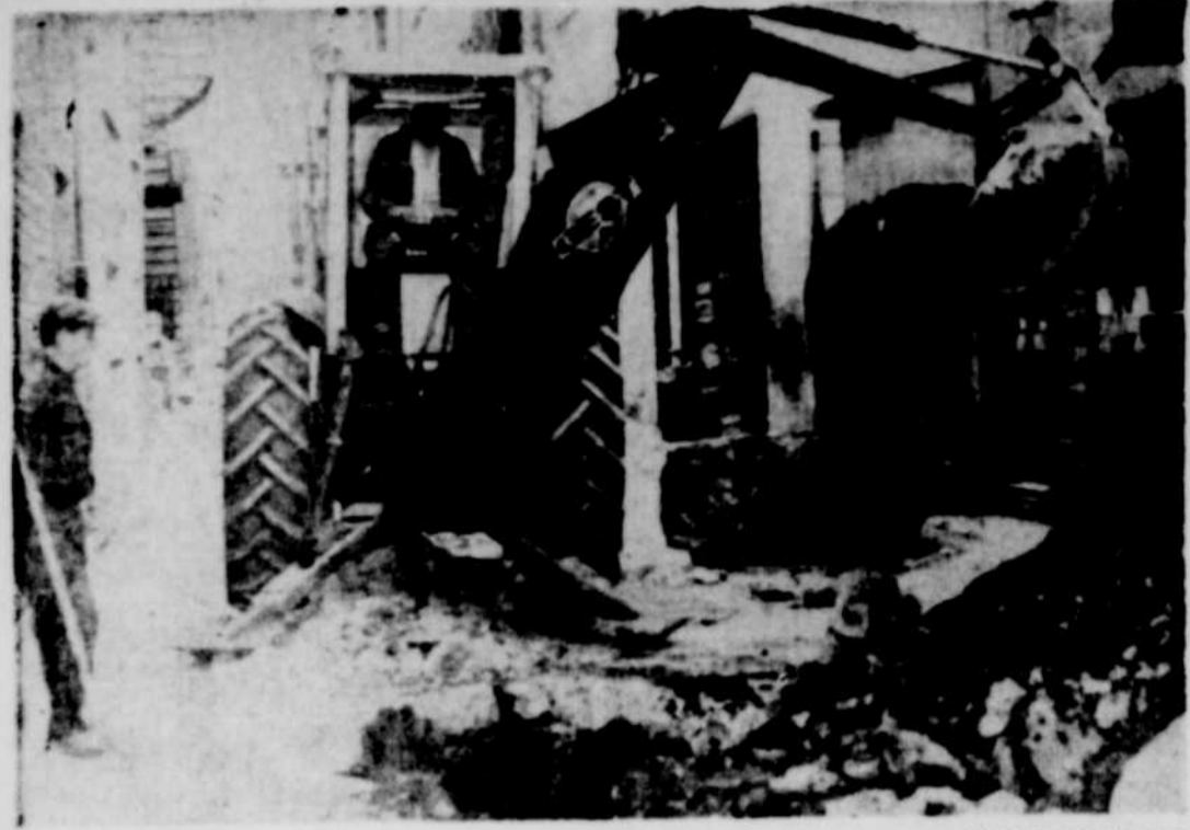
LES OUVRIERS qui travaillent à enfouir les transformateurs dans la terre dans la rue entre la 4e et la 5e rue ont eu une surprise, jeudi, quand la pelle mécanique que nous voyons à droite. On a eu toutes les misères du monde à la sortir du trou, afin de continuer le travail.
