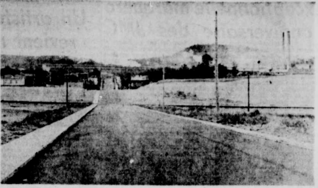
LA TRAVERSE de la rue St-Michel sous son nouvel aspect! La rue, baissée de plusieurs pieds, recouverte de béton bitumineux, offre une plus grande visibilité et une sécurité augmentée aux automobilistes. A l'arrière-plan, la fumée s'échappant dans un gris d'automne des hauts fourneaux de l'usine de la Canadian International Paper. La ville de La Tuque vient de compléter un vaste programme de pavage sur plusieurs artères de la municipalité.
