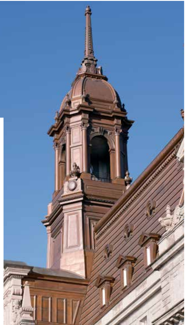
Restauration de l'hôtel de ville de Montréal, Affleck de la Riva architectes Photo : Alain Laforest
