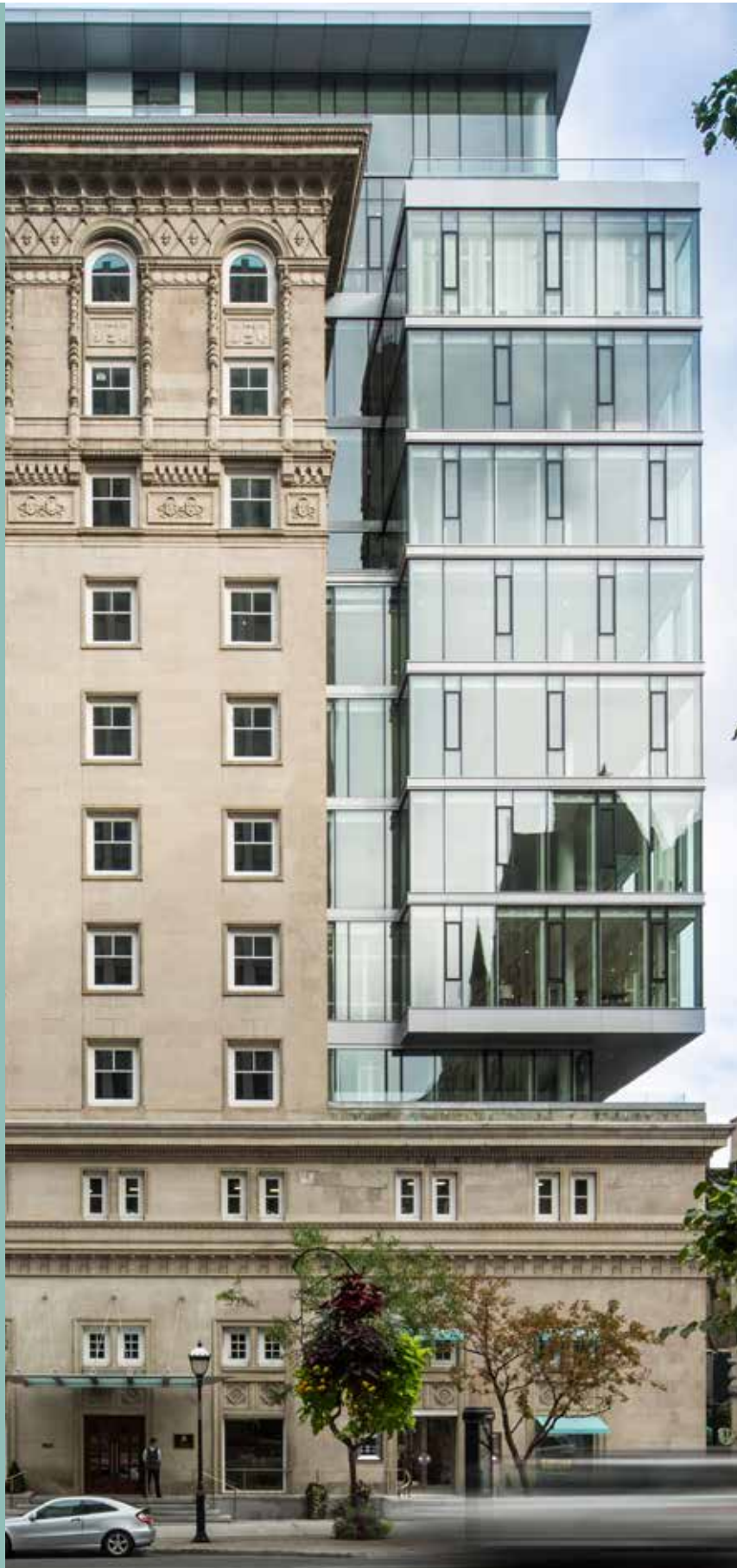
Transformation et agrandissement du Ritz-Carlton Montréal, Provencher Roy architectes Photo : Stéphane Groleau
