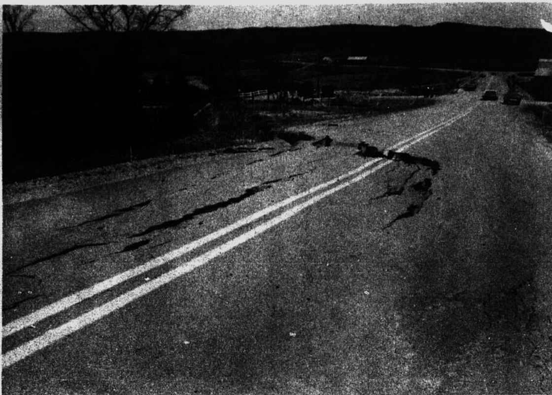
pouvons voir sur la photo de droite la faille qui va à travers le champ de la route à la rivière Drolet; à l'arrière-plan, l'endroit où la tige d'une foreuse a percé, le 18 mai dernier, la poche d'eau souterraine.
