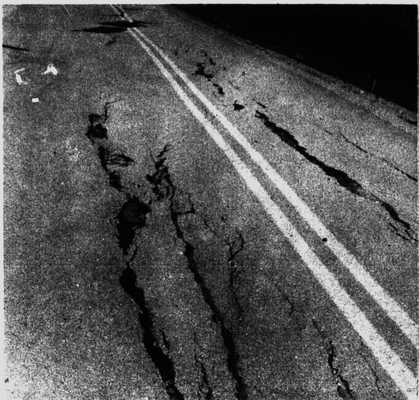
LAC DROLET: Nous apercevons sur ces deux photographies la section effondrée de la route qui relie Lac-Drolet à St-Ludger. Cette section qui couvre quelques centaines de pieds présente une dénivellation d'une dizaine de pouces par rapport aux sections voisines. Nous
