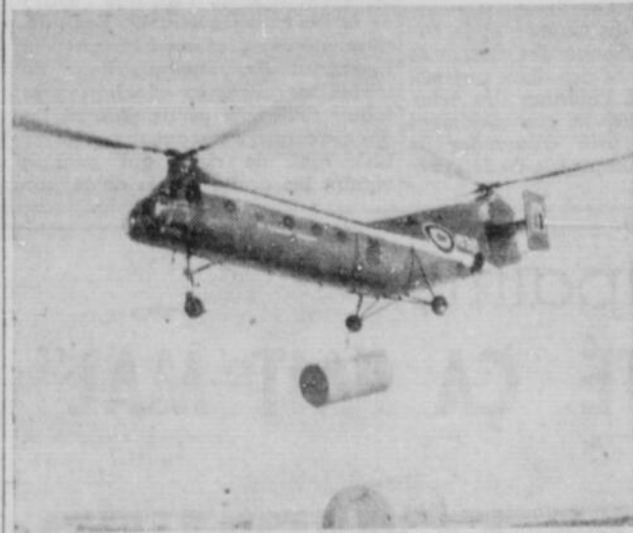
(Photo Défense Nationale) CHEVAL DE BAT AERIEN — Un gros hélicoptère Piasecki H-21, un de plusieurs qui travaillent à la construction du réseau Mid-Canada d'alerte précoce, soulève un lourd réservoir d'acier qu'il transportera vers un des postes de détection quelque part sur le 55e parallèle de latitude. Les hélicoptères Piasecki et Sikorsky du CARC jouent un rôle très important dans la construction du réseau dont plusieurs postes se trouvent dans des régions absolument inaccessibles.
